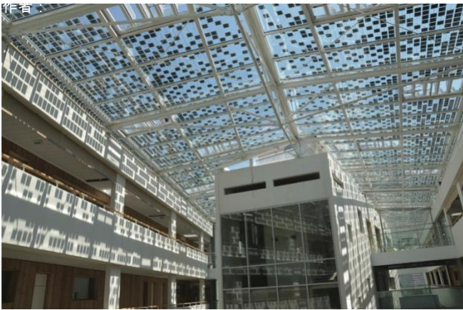
图18：法国库尔布瓦一所学校使用的c-Si太阳能电池半透明BIPV天窗。版权：MT ECH & CSTB。
