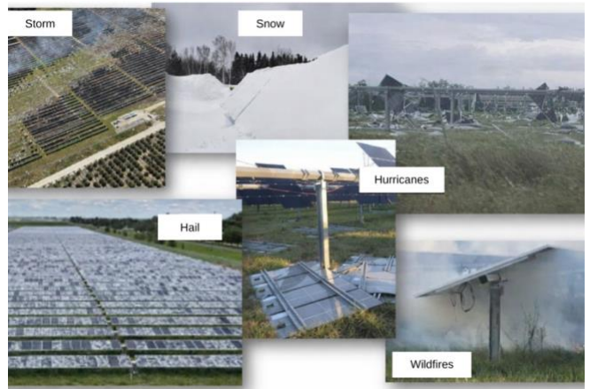
图8：因极端天气事件而损坏的光伏系统。图片：劳里·伯恩哈姆，桑迪亚国家实验室。
