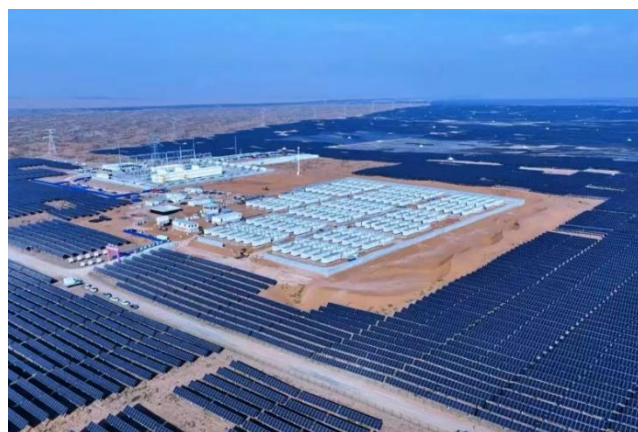
图 19: 龙源电力孟家湾储能电站
