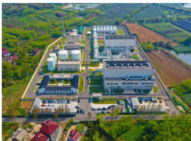
图 22：华能金坛盐穴压缩空气储能项目
