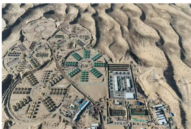
图 24：华电乌鲁木齐光伏基地独立新型储能示范项目
