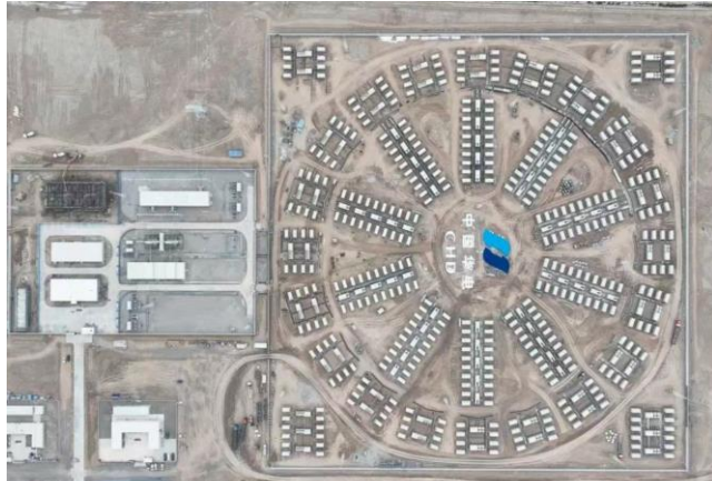
图 25：华电喀什百万储能项目
