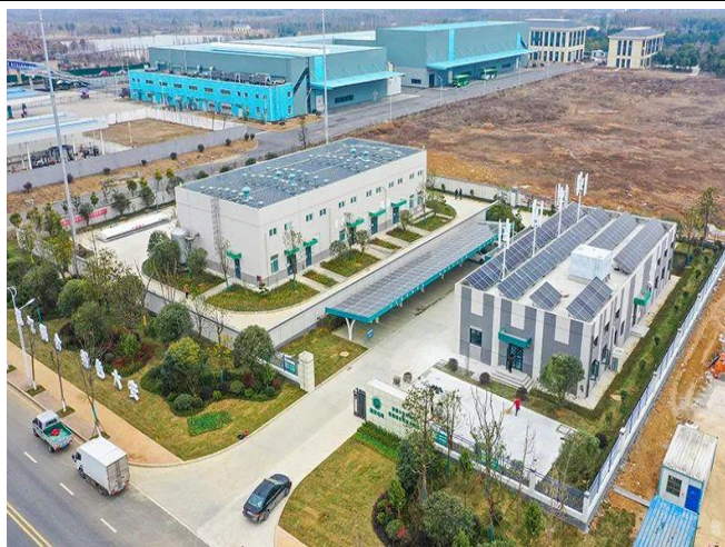
图 15：安徽六安兆瓦级氢能综合利用示范站
