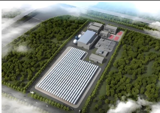
图 35：中核百兆瓦先进压缩空气储能示范项目
