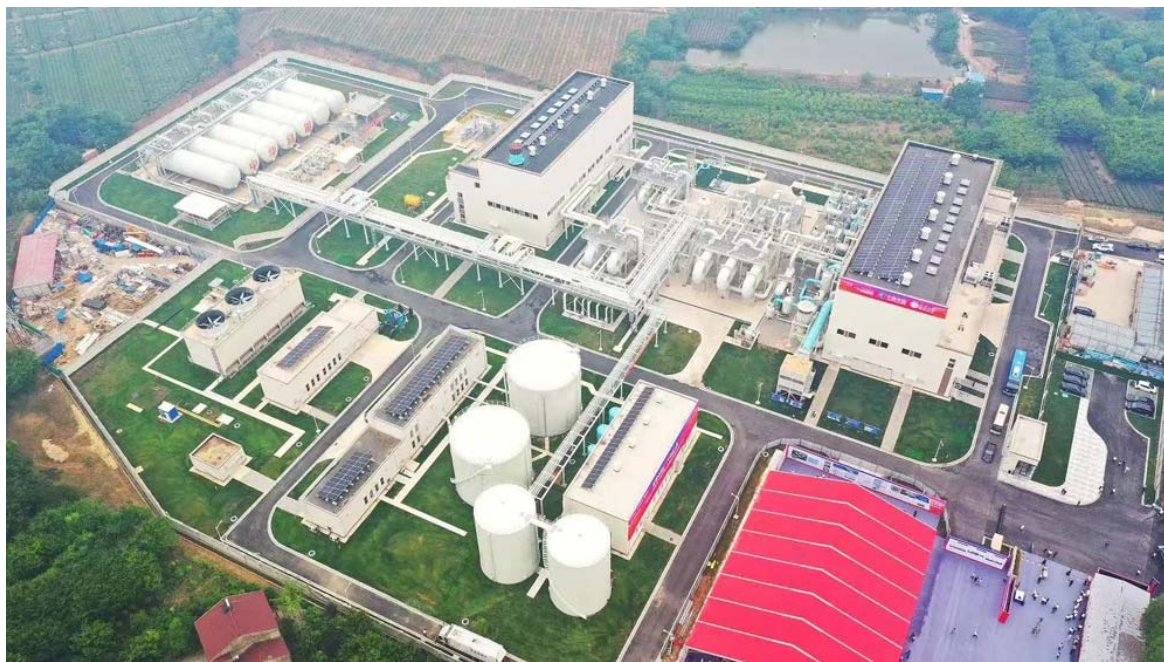
图：金坛盐穴压缩空气储能电站
